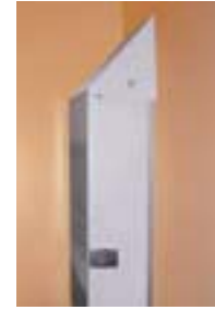
▲施工例 / 制御盤用傾斜カバー
