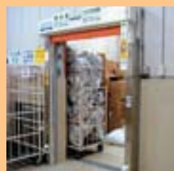
▲施工例(スーパーマーケット)
