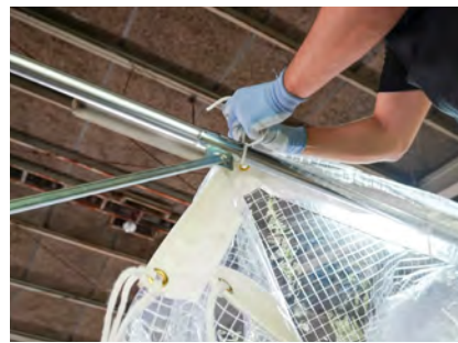
天幕ハトメにロープが付いていますので、パイプへ結びます。
