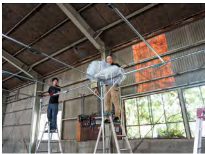
中柱・桁上へ天幕を乗せます。
