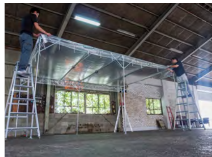
すべてのロープを結べば天幕の固定が完了です。
